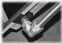
Monte el tapón macho de 1/2" para el drenaje del circuito solar.
